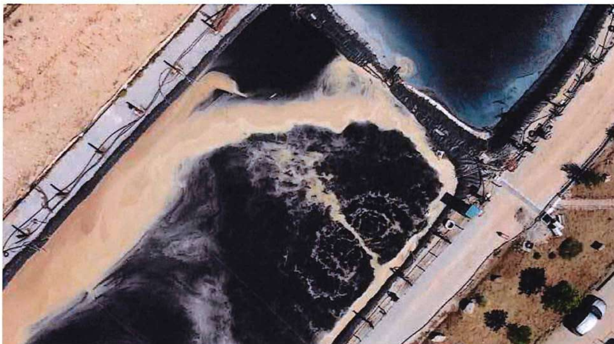
FIGURA 25 – Lagoas de armazenamento de lixiviados do CTRSU de Tondela da AMRPB.
