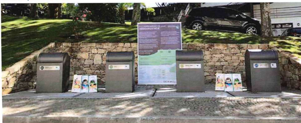
FIGURA 10 – Bateria de deposição seletiva trífuxo enterrada instalada em 2020 no território do SGRU titulado pela AMRPB.
