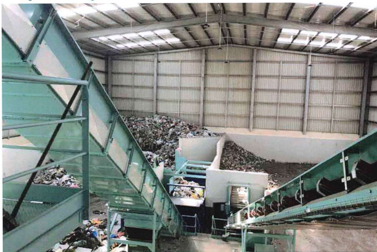
FIGURA 16 – Setor reconstruído do edifício da Central de Triagem de embalagens do CTRSU de Tondela.
