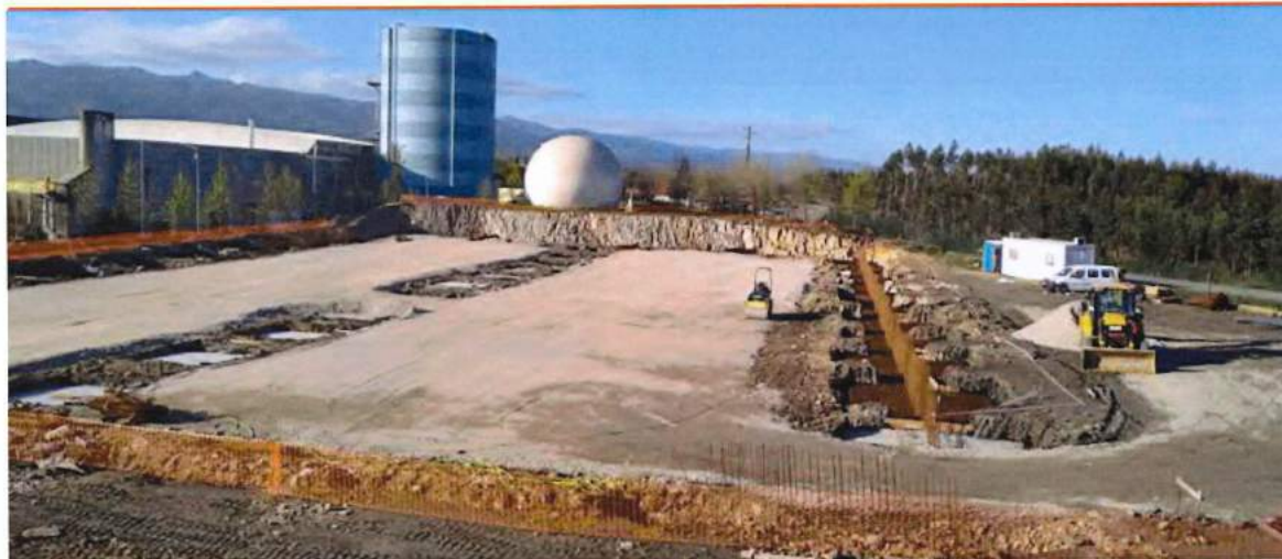
Figura 30 • Futuro parque de compostagem de biorresíduos
