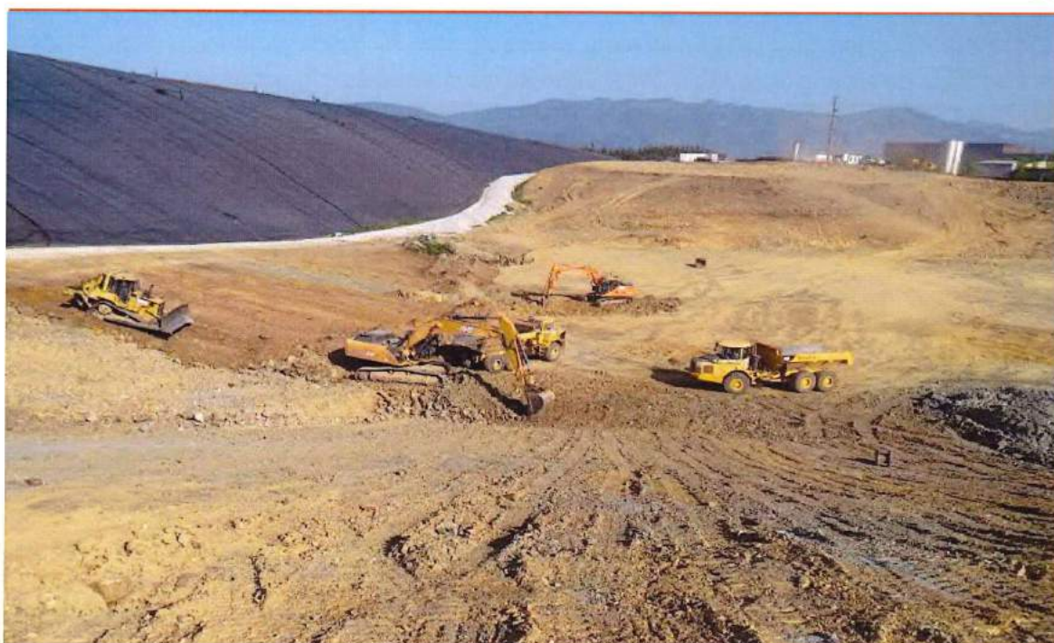
Figura 27 • Terraplanagem da nova célula de confinamento técnico do aterro sanitário
