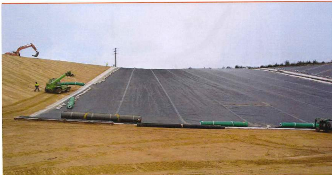
Figura 28 • Impermeabilização da nova célula de confinamento técnico do aterro sanitário
